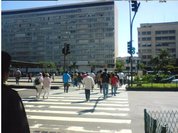
Figura 2 – Sistema informacional num ponto de travessia da Av. Presidente Vargas: semáforos para veículos e pedestres, pintura no piso (faixa de segurança e linha de contenção de veículos), gradil nas ilhas de refúgio e rampas para pedestre.
